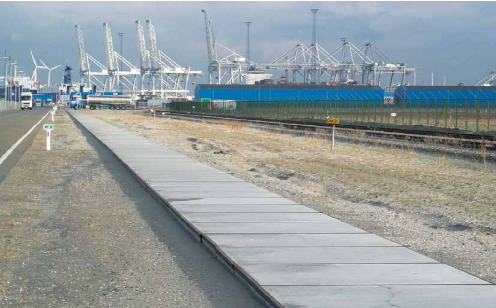
Project Antarcticaweg – Maasvlakte Tijdelijk fietspad Cordon® H Vloerplaat met hoekrand 200 x 200 x 14 cm
