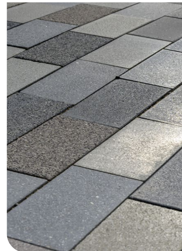
Proefvlak met diverse nabewerkingen.
