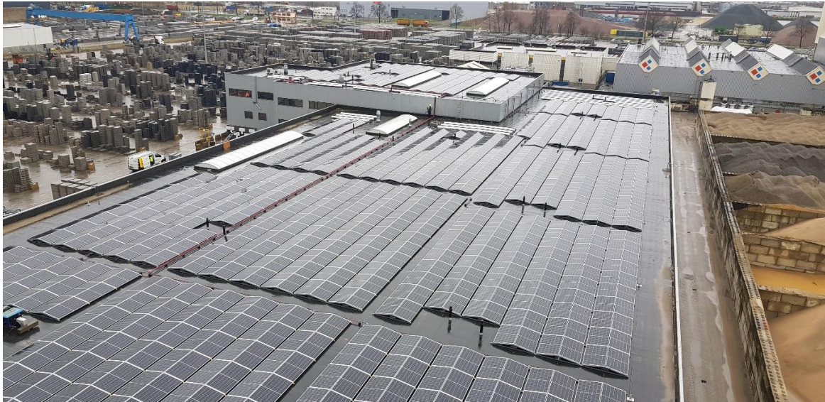
Foto 1. Dak Specials-fabriek locatie Amsterdam met zonnepanelen
