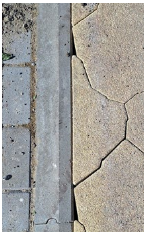
Wigvormige naad naast de bandenlijn.
