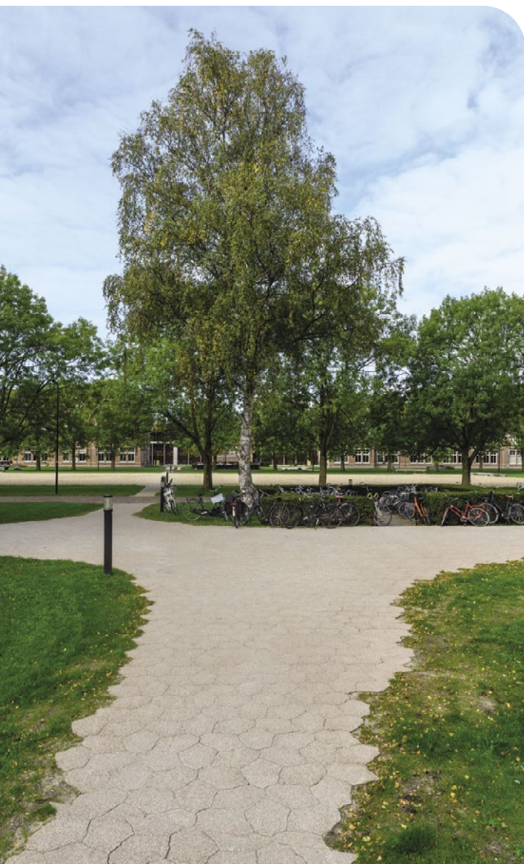
Bestrating Zarafa Breccia met CERO cementvrij onderbeton.
