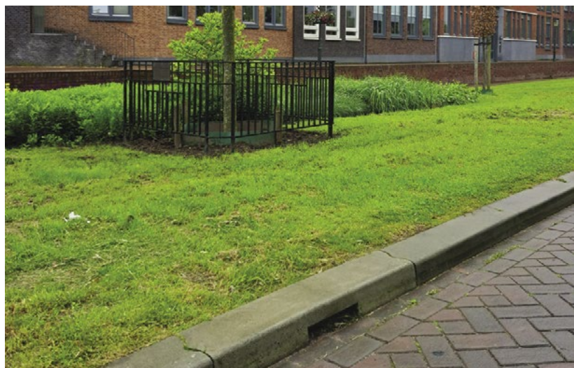
Waterbufferende groenstrook met wadiband.
